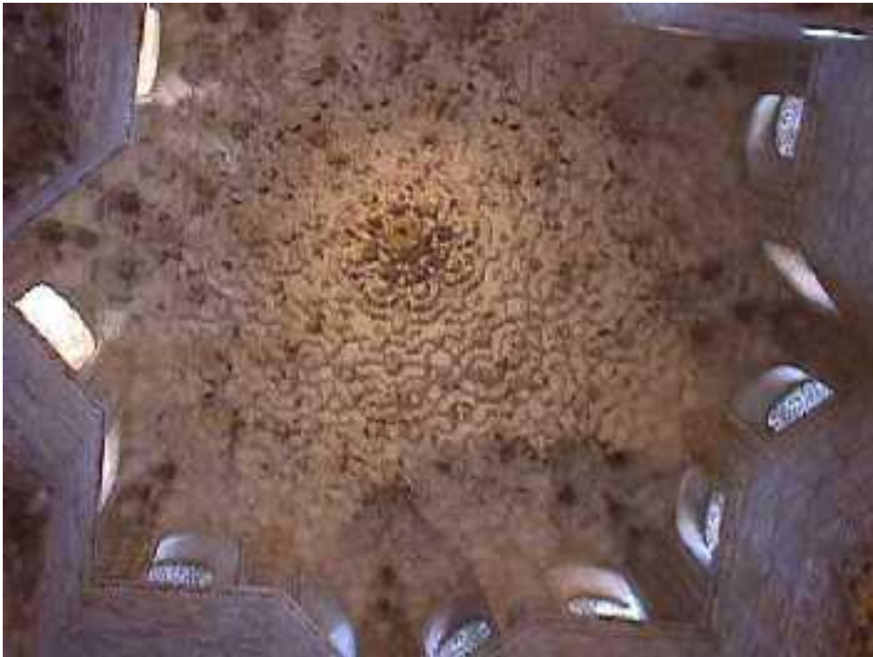
Bóveda de Mocárabes en la Sala de Abencerrajes
